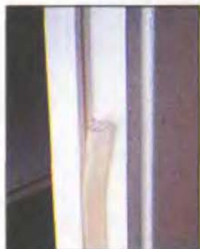
Полые уплотнители, укладываемые в выбранные фрезой пазы, при необходимости легко заменить.
