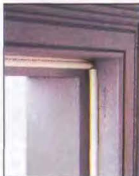
Со стороны замка уплотнитель укладывают в фальц дверной коробки, а со стороны петель приклеивают к боковой кромке.
