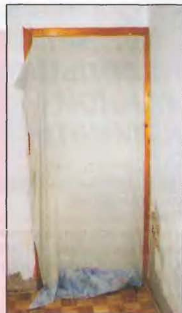
Полотно должно полностью закрывать дверной проем и припуском свисать на пол. Щели между стеной и дверной коробкой укрывают ненужными наличниками.
