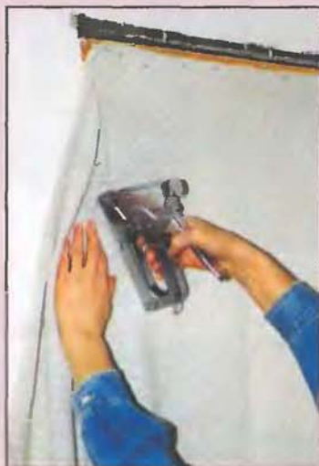
Полотно из плотной ткани прибивают по периметру к дверной коробке гвоздями или скобками с помощью степлера, оставив зону для прохода.
