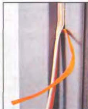
Прежде чем приклеить уплотнительную ленту, с нее надо снять защитную бумагу.
