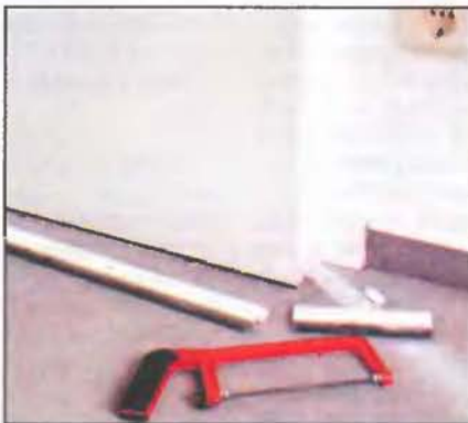
Раскroив щеточный уплотнитель по длине ножовкой по металлу, на него снова надевают штатные наконечники.
