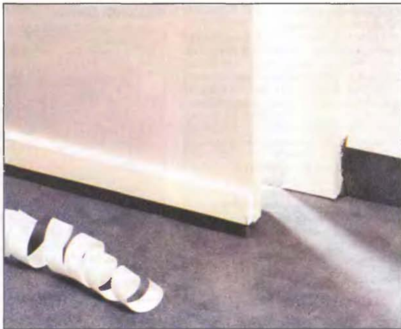
Приклеенная снизу к дверному полотну щетка препятствует возникновению сквозняка в комнате.
